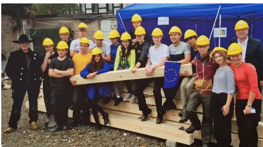
Fin de chantier avec les élèves à Osterode © W. Böttner, 2017.
