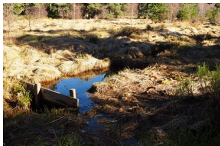
Barrage-seuil sur le drain qui traverse la tourbière de Gimel
